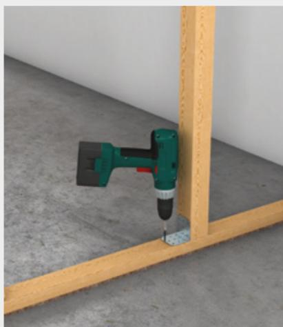
Montage der Holzständer mit Stiftnagel oder Stahlwinkel
