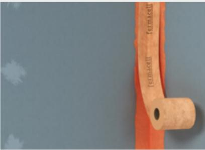
fermacell™ Dichtband in die zuvor aufgetragene, noch feuchte fermacell™ Flüssigfolie drücken...
