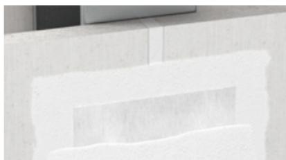
Ebenso die versenkten Köpfe der Befestigungsmittel sowie etwaige Beschädigungen verspachteln. Evtl. Unebenheiten können nach dem Aushärten der ersten Verspachtelung plangeschliffen werden (Schleifgitter oder Schleifpapier, Körnung 60). Nach dem Abfegen des Schleifstaubes die Feinspachtelung vornehmen.
