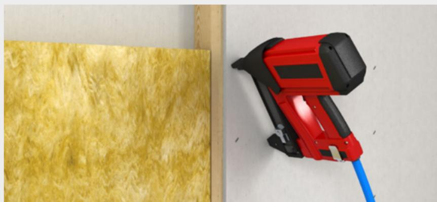
Klammern auf Holz-Unterkonstruktion
