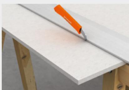
Die Platten mit dem fermacell™ Plattenreißer oder einem stabilen Klingemesser mithilfe einer Führung einritzen.
