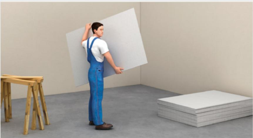
Einzelne fermacell® Gipsfaser-Platten hochkant tragen
